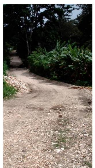
Imagen de los caminos donde se ha colocado material de base durante los trabajos de rehabilitación
