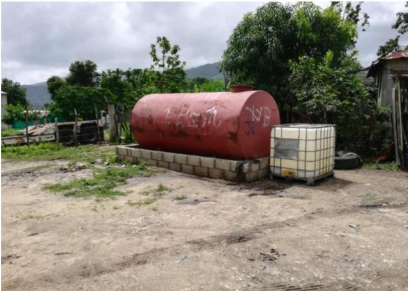
Imagen del tanque de combustibles con su muro de contención
