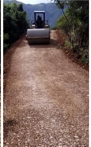
Imagen de los equipos durante los trabajos de rehabilitación
